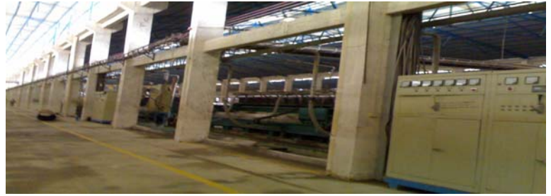
窑炉生产线变频同步调速系统
